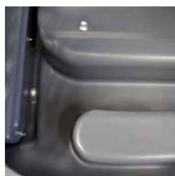
CANALES DE DESAGÜE
